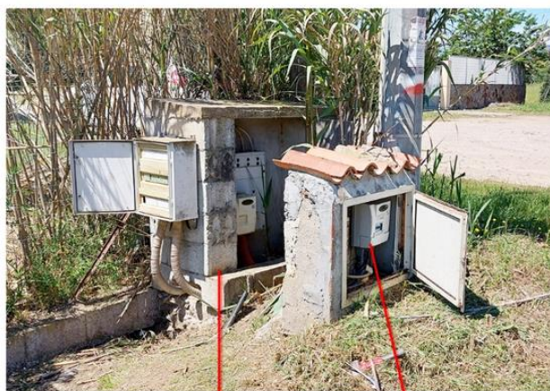
contattore e box con interruttori elettrici
